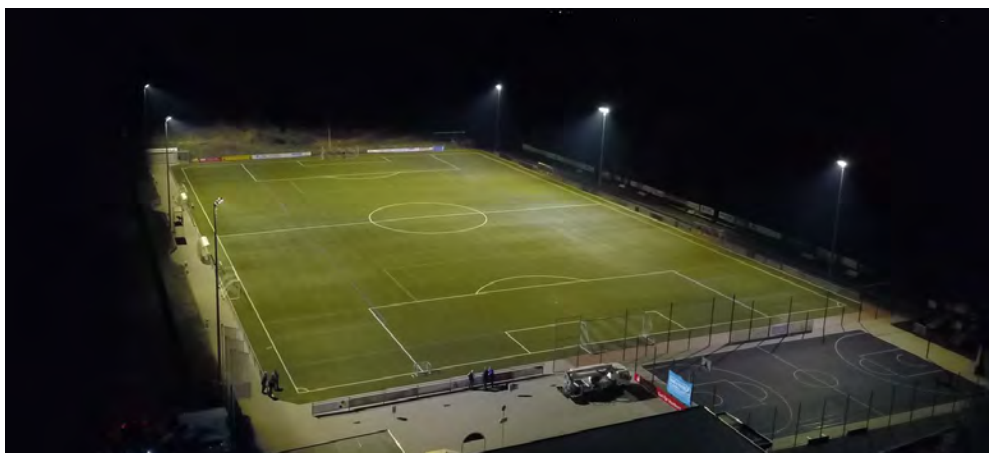
6 Mastanlage mit 8 asymmetrischen LED-Scheinwerfer
