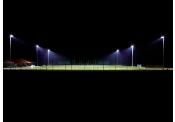
6 Mastanlage mit 12 Planflächenscheinwerfer 2000W
