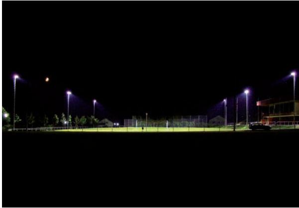
6 Mastanlage mit 8 Planflächenscheinwerfer 2000W
