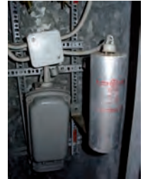
PCB-haltige Kondensatoren
