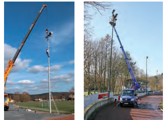
Maststellung u. Servicearbeiten mit einer Hubarbeitsbühne
